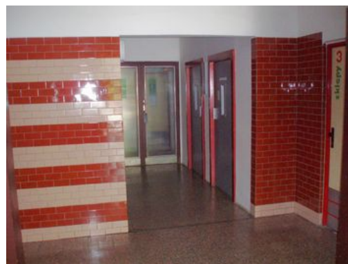
Dům č.p. 1888 - společné prostory v domě
