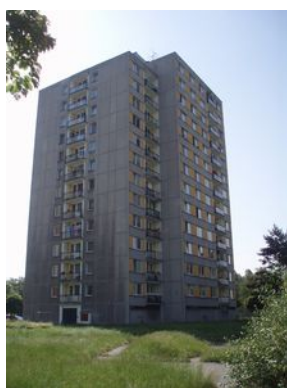
Dům č.p. 1888 - pohled severozápadní
