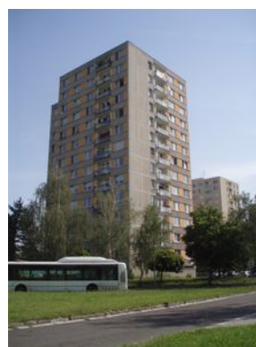
Dům č.p. 1888 - pohled jihozápadní
