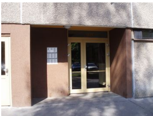
Dům č.p. 1888 - vstup do domu
